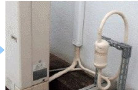
配管施工後に保温処理を施します。
