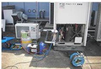
現状使用している冷媒ガスを抜きます。
