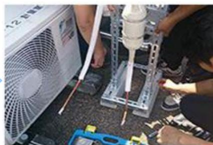
切断した配管に $\alpha$ -HTを取り付けます。
